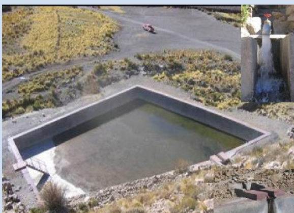
Gráfico 6 Obra de estanque de agua y cerca de protección de áreas de pastoreo
